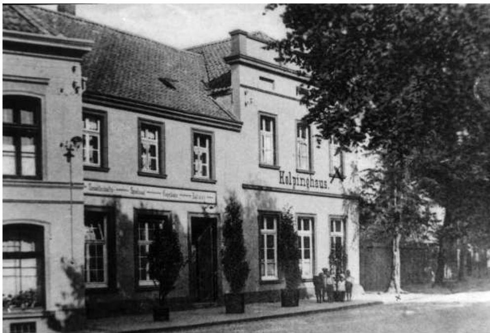
Das Kolpinghaus in Xanten vor der Bombardierung
